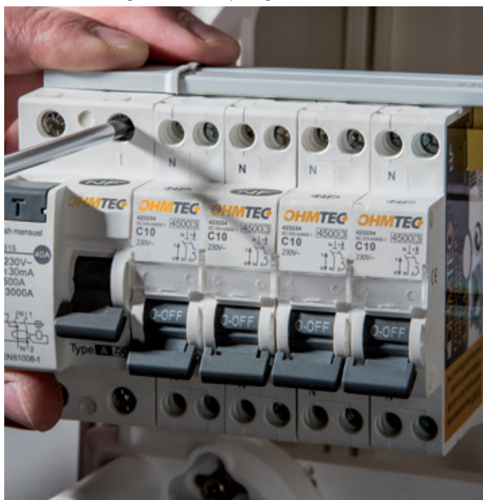
Illustration de montage de la barre de pontage à vis
